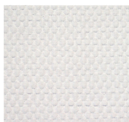
Närbild av ytskikt
